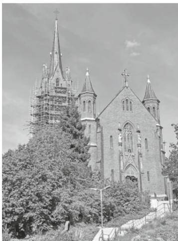
Aktuell ist an unserem Kirchturm in Aßmannshardt wieder ein Gerüst zu sehen - das Hauptprojekt zur Sanierung von Glockenstuhl und Innenbereich Kirchturm geht somit in die Phase der Umsetzung. Bedingt durch zu große Schwingungen bei Glockenläuten im Kirchturm ist eine vollumfassende statische Optimierung von Kirchturm und Glockenstube unumgänglich. Die anstehenden Arbeitsumfänge lassen sich wie folgt kurz zusammenfassen:
