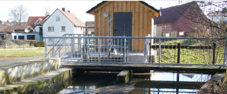
Schemmerhofen geht mit der BürgerEnergiegenossenschaft neue, innovative Wege in der kommunalen Energiepolitik und Energieerzeugung.
