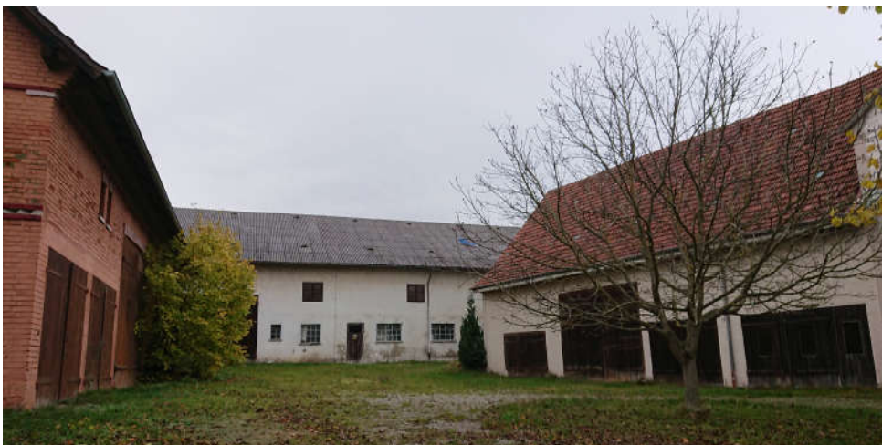
Foto 3: Übersicht Hofstelle Wasserberg 3 aus Osten
