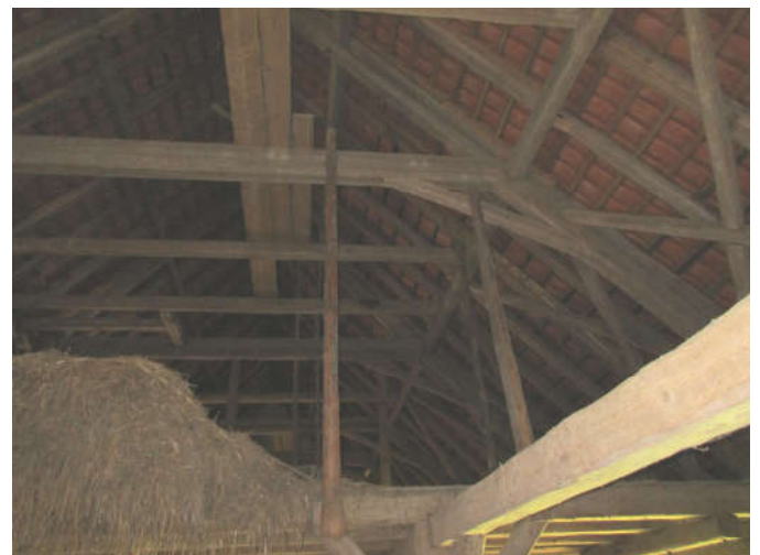
Foto 2: Wirtschaftsgebäude Innen Strohlager
