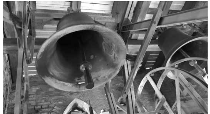
Neuer Holzfußboden über der Glockenstube
