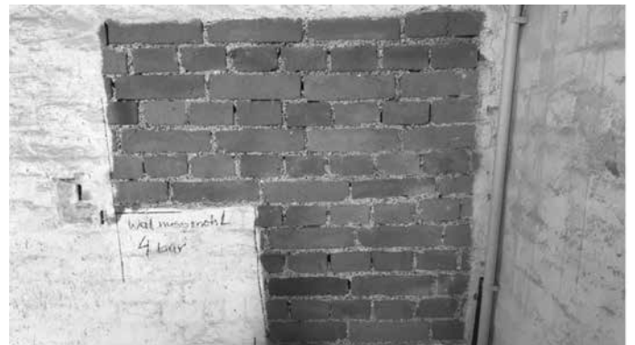
Versuchsfeld an der inneren Ziegelwand im Kirchturm
